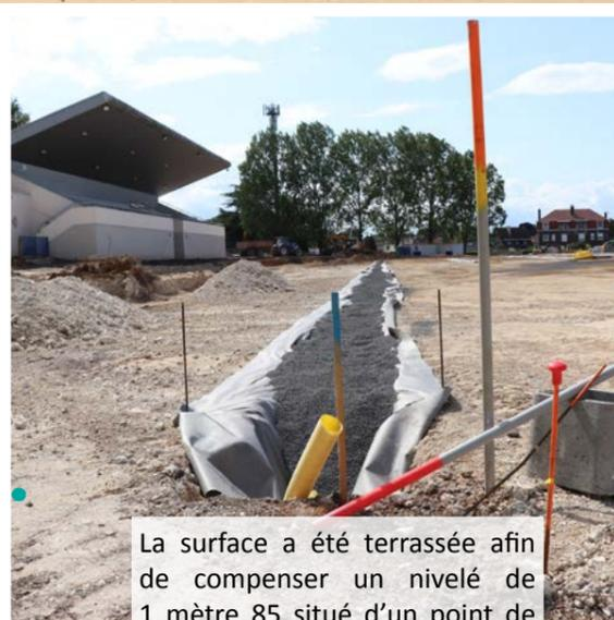
La surface a été terrassée afin de compenser un nivelé de 1 mètre 85 situé d'un point de corner à un autre. Les systèmes de drainages d'eaux pluviales d'arrosage automatique ont été installés, puis, les différentes couches du terrain hybride ont été étalées. Les six couloirs de la piste d'athlétisme seront recouverts d'un enrobé puis d'une matière en résine pour renforcer son adhérence.
